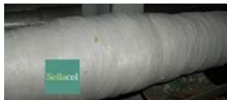
Parche de reparación multimaterial
